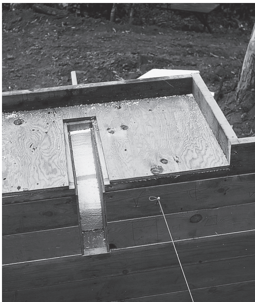
The filler in position before the pour
