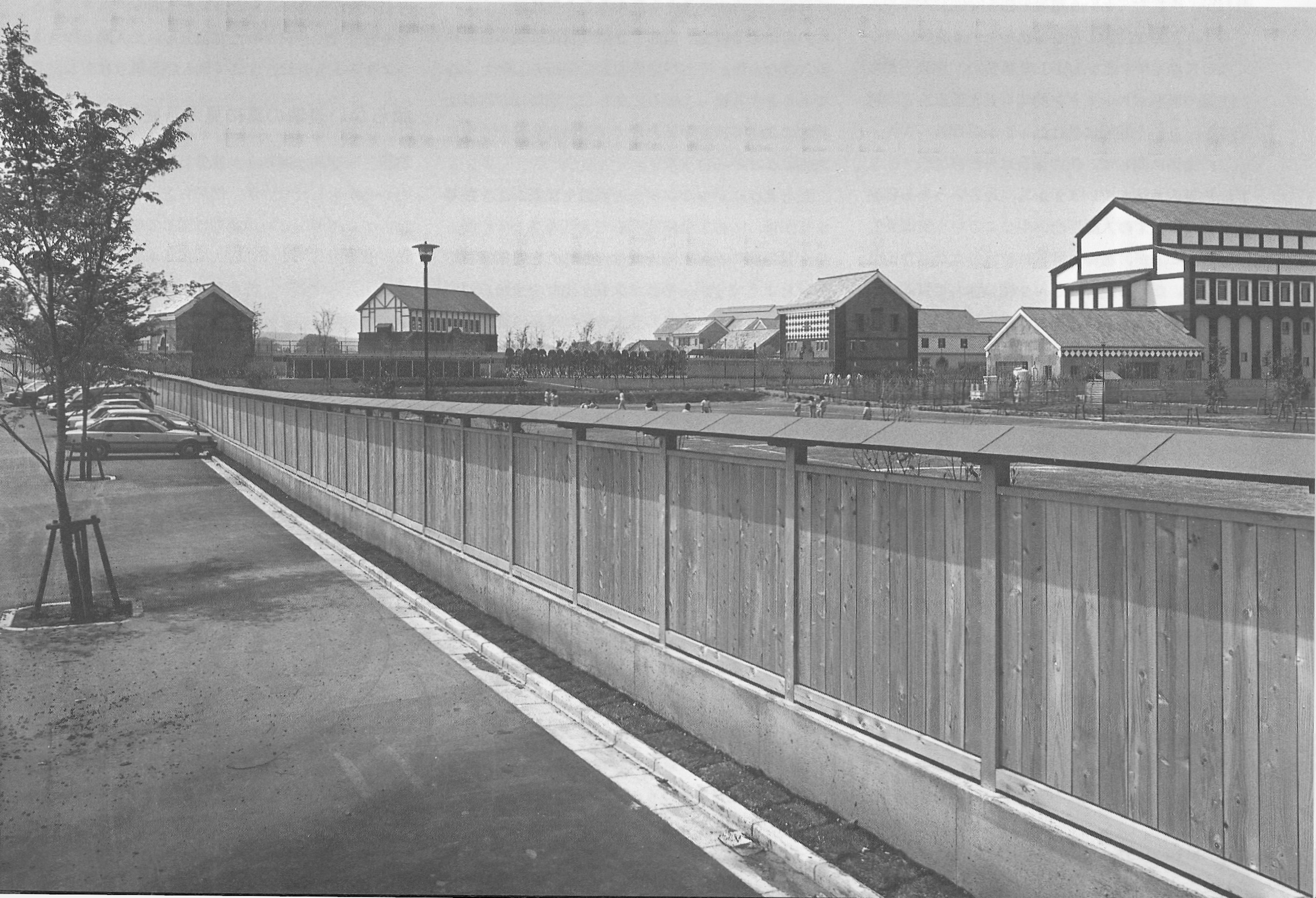
29 敷地全体を塀が取り囲む
