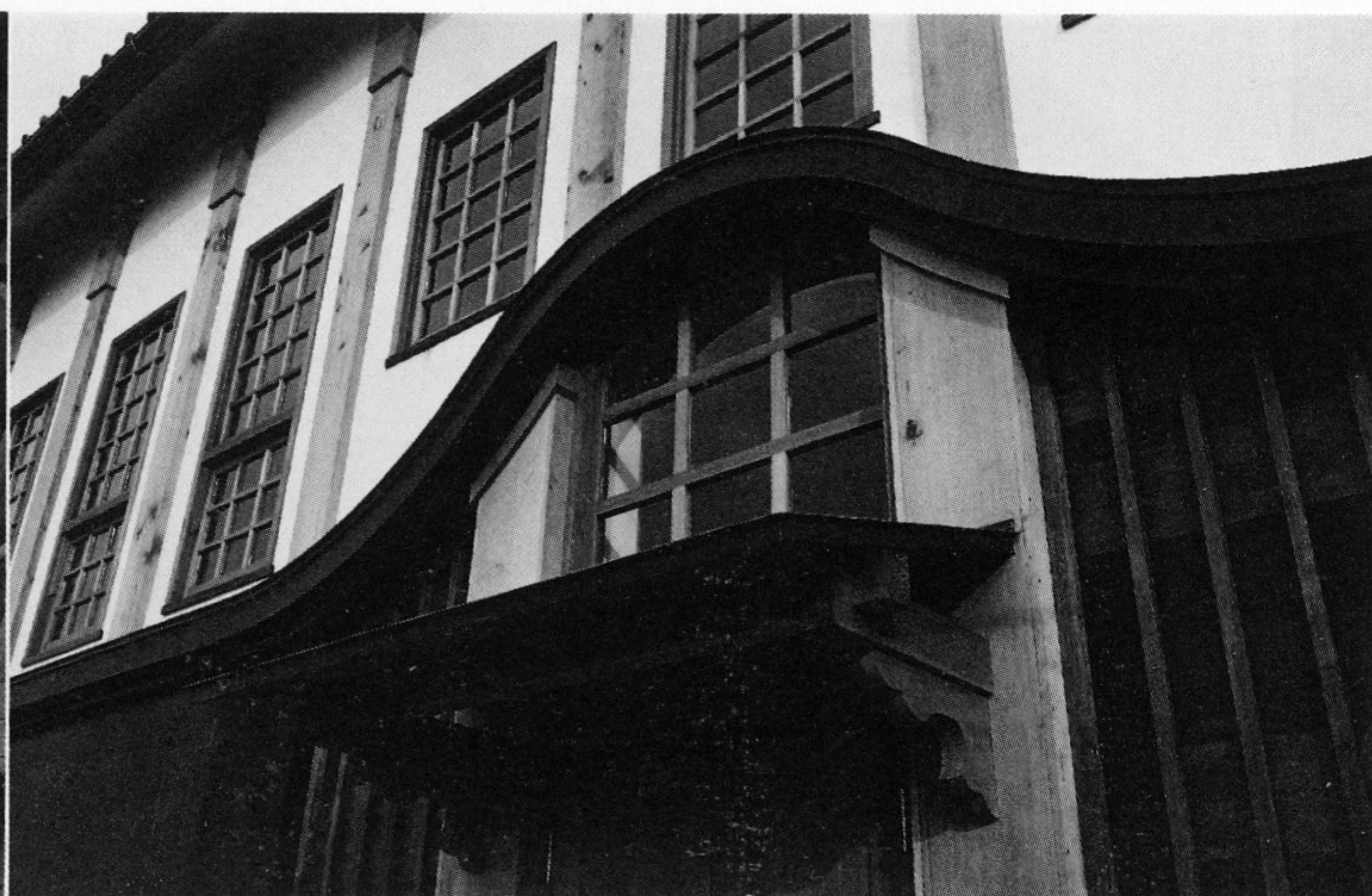
武道場正面入口上部
