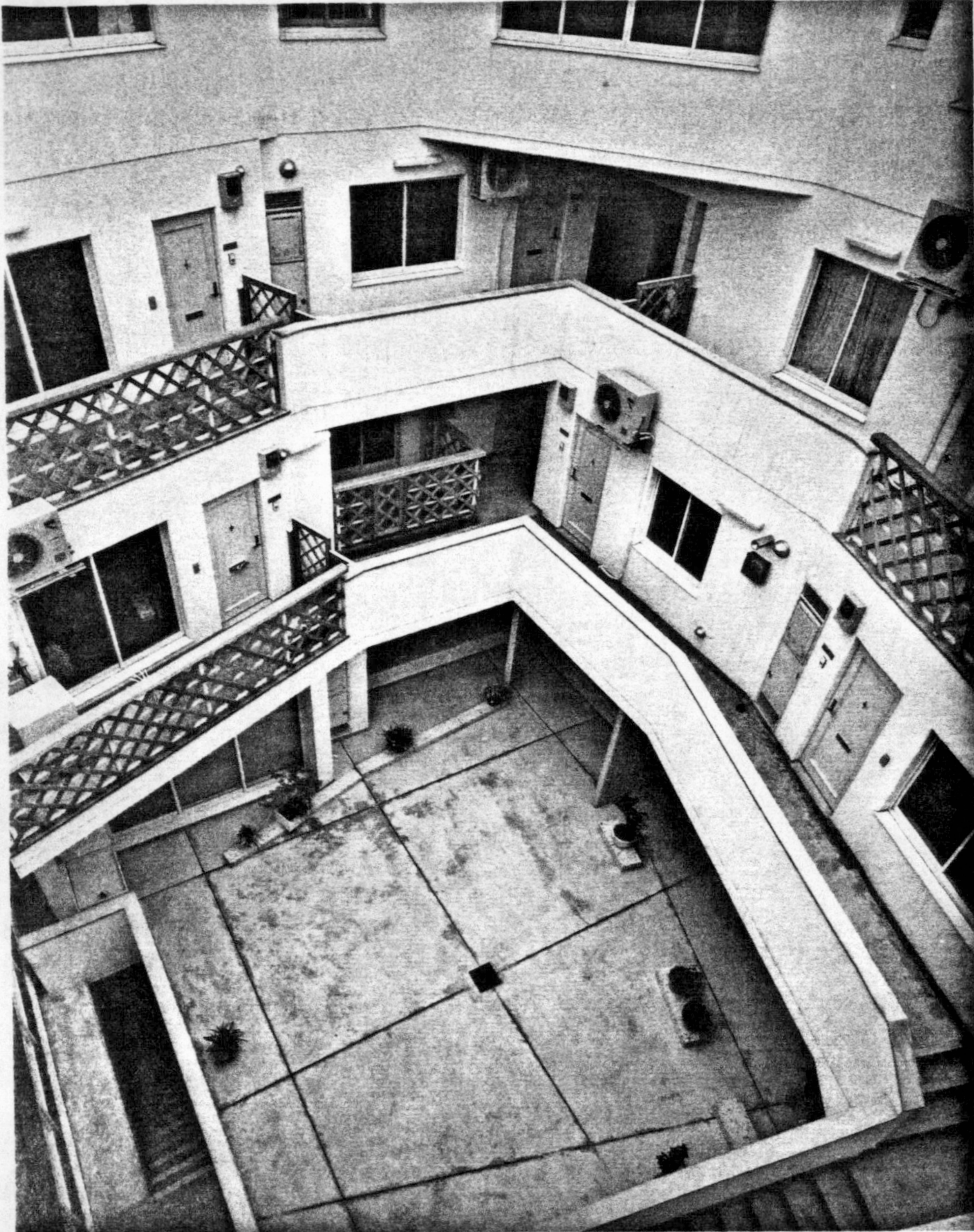
中庭全景。効率良く日照を得るため、建物はすり鉢状にセットバックしている
