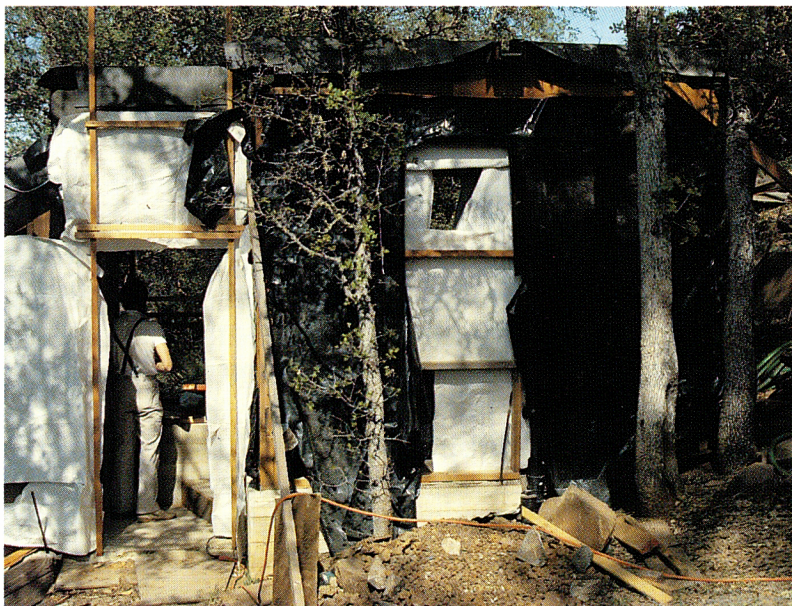
De proefindeling van de gevel The mock-ups of the façade
