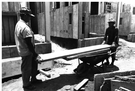
Casting interior and exterior non-structural panel components. Fundición de componentes de paneles no estructurales interiores y exteriores.
