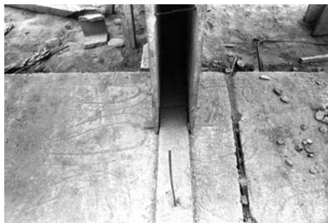
Fabricación de paneles de pared. Moldes en metal prensado con marco de madera. Fundición sobre el piso de la casa. Se vierte 1 cm de hormigón en el molde, se pone encima una malla previamente cortada y se empujan debajo de la malla, en la mezcla húmeda, los espaciadores con las partes inferiores en ángulo. Se vierte sobre la malla 1 cm de hormigón, que se afina alrededor de los pernos y se deja áspero para mejorar la adherencia del hormigón que luego será vertido en la cavidad del componente.
