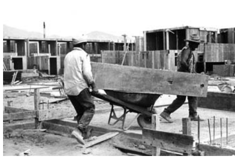
Moving complete wall panels and placing plastic conduits in wall component cavity before erection. Transporte de los paneles de pared completos y colocación de conductos de plástico en la cavidad del componente de pared antes de su levantamiento.
