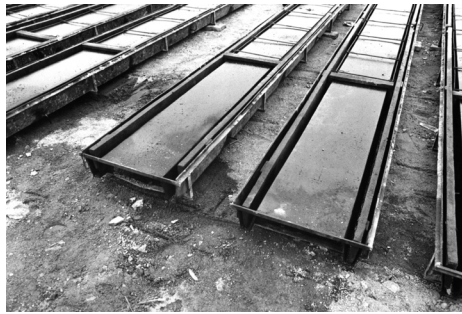
Pressed metal molds for roof components. Note preformed re-bar assemblies in molds and wood end stops for making components of any length. Moldes de metal prensado para componentes de techo. Nótese los ensamblajes preformados de barras de refuerzo y los extremos en madera para fabricar componentes de cualquier longitud.
