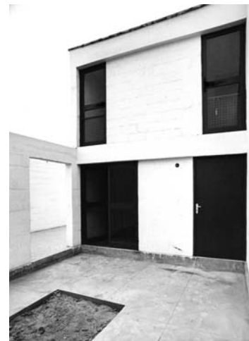
Entrance courtyard. Two story house. Note opening in wall and narrow bay for future expansion of house. Patio de entrada, casa de dos pisos. Nótese la abertura en la pared y el espacio estrecho para futura expansión.
