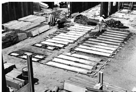
Casting interior and exterior non-structural panel components. Fundición de componentes de paneles no estructurales interiores y exteriores.
