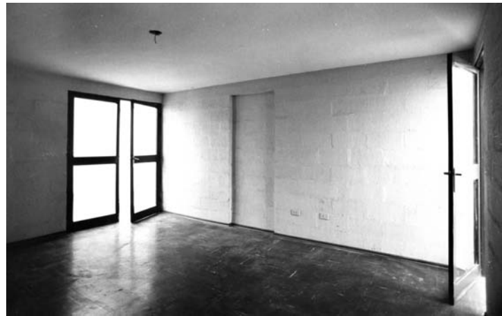
Interior of the main bay. Note through ventilation. Block panel in door opening can be removed in future to gain access to narrow bay for expansion. Interior del espacio principal. Nótese la ventilación cruzada. El panel de bloque en la abertura de la puerta se puede retirar en el futuro para acceder al espacio estrecho durante la expansión.
