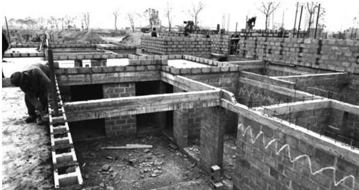
General views of construction. Concrete block walls reinforced horizontally and vertically at designed points with grouted cavities. Long and cross tie-beams cast on site. Note beams over openings cast in two lifts. Beams have rebated section to receive precast roof/floor components. Vistas generales de la construcción. Paredes de bloques de hormigón reforzadas horizontal y verticalmente con cavidades para mortero en los puntos establecidos en el diseño. Vigas de amarre largas y perpendiculares fundidas in situ. Nótese las vigas fundidas en dos tramos sobre las aberturas; tienen ranuras para recibir los componentes prefabricados de techo/piso.
