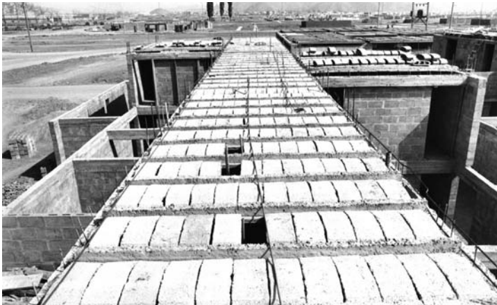
Precast roof/floor components in position ready for top on-site concrete. Prestressed inverted tie-beams with fitted concrete blocks in between. Componentes prefabricados de techo/piso en posición para recibir la capa superior de hormigón. Vigas de amarre pretensadas invertidas. Bloques de hormigón dispuestos entre las vigas.
