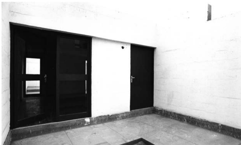
Entrance courtyard. One story house. Note pavement opening for shade tree. Patio de entrada, casa de un piso. Nótese la abertura del pavimento para un árbol de sombra.
