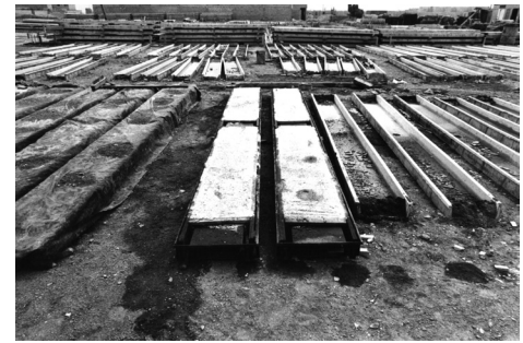
Production of roof components. Two newly cast components in middle. Black plastic sheeting to assist curing placed over filled molds on left. Demolded components on right. Note ends of upside down units are blocked with earth and filled with water to assist curing. Producción de componentes de techo. En el medio, dos componentes recién fundidos. A la izquierda, láminas de plástico negro sobre moldes rellenos, para ayudar al curado. A la derecha, componentes desencofrados. Nótese que los extremos de las unidades invertidas están bloqueados con tierra y llenos de agua para ayudar al curado.
