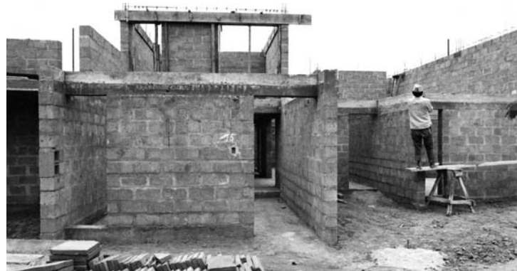
General views of construction. Concrete block walls reinforced horizontally and vertically at designed points with grouted cavities. Long and cross tie-beams cast on site. Note beams over openings cast in two lifts. Beams have rebated section to receive precast roof/floor components. Vistas generales de la construcción. Paredes de bloques de hormigón reforzadas horizontal y verticalmente con cavidades para mortero en los puntos establecidos en el diseño. Vigas de amarre largas y perpendiculares fundidas in situ. Nótese las vigas fundidas en dos tramos sobre las aberturas; tienen ranuras para recibir los componentes prefabricados de techo/piso.
