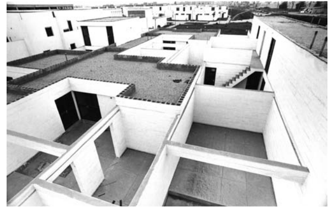
Top view of cluster. One and two story houses. Note all tie-beams are in position to guide the future placement of walls on the plan form expansion. Beams are rebated to receive precast floor/roof components. Vista superior de la agrupación. Casas de uno y dos pisos. Nótese que todas las vigas de amarre están dispuestas para guiar la futura ubicación de muros en la expansión de la planta. Las vigas tienen ranuras para recibir los componentes prefabricados de piso/techo.
