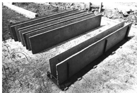
Steel jigs for accurately assembling wall components. Panel lowered into jig and distance pins welded together. Components are then rigid and can be lifted out. Plantillas de acero para ensamblar con precisión los componentes de la pared. El panel es instalado en la plantilla y los pernos espaciadores son soldados entre sí. Los componentes, ahora rígidos, pueden ser levantados.
