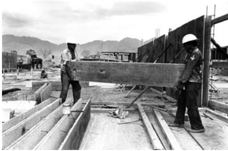
Ferro-cement, lightweight double panel wall components. Note electric boxes cast into panels. Componentes de pared de doble panel en ferrocemento ligero. Nótese las cajas eléctricas fundidas en los paneles.
