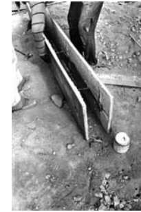
Moving complete wall panels and placing plastic conduits in wall component cavity before erection. Transporte de los paneles de pared completos y colocación de conductos de plástico en la cavidad del componente de pared antes de su levantamiento.
