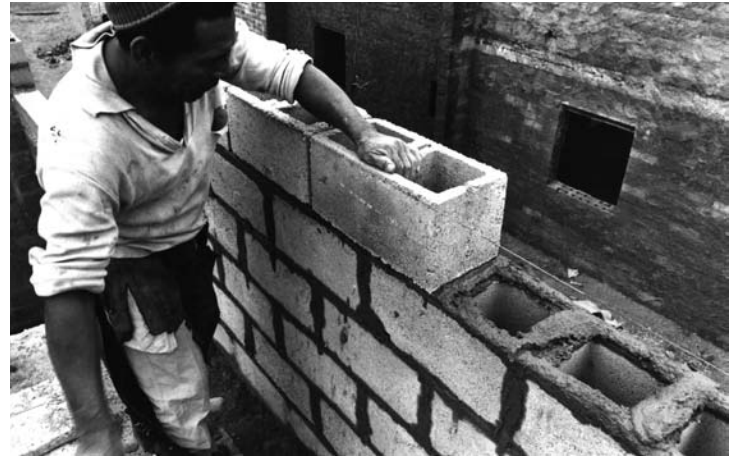
PREVI concrete blocks. Bloques de hormigón PREVI.
