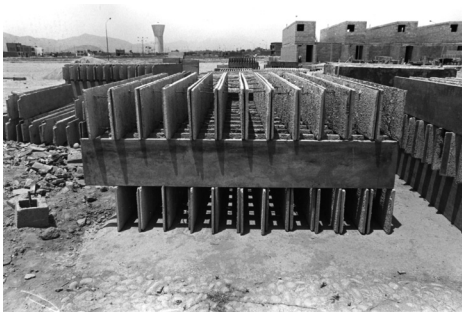
Wall components stacked ready for use. Componentes de pared apilados, listos para su uso.
