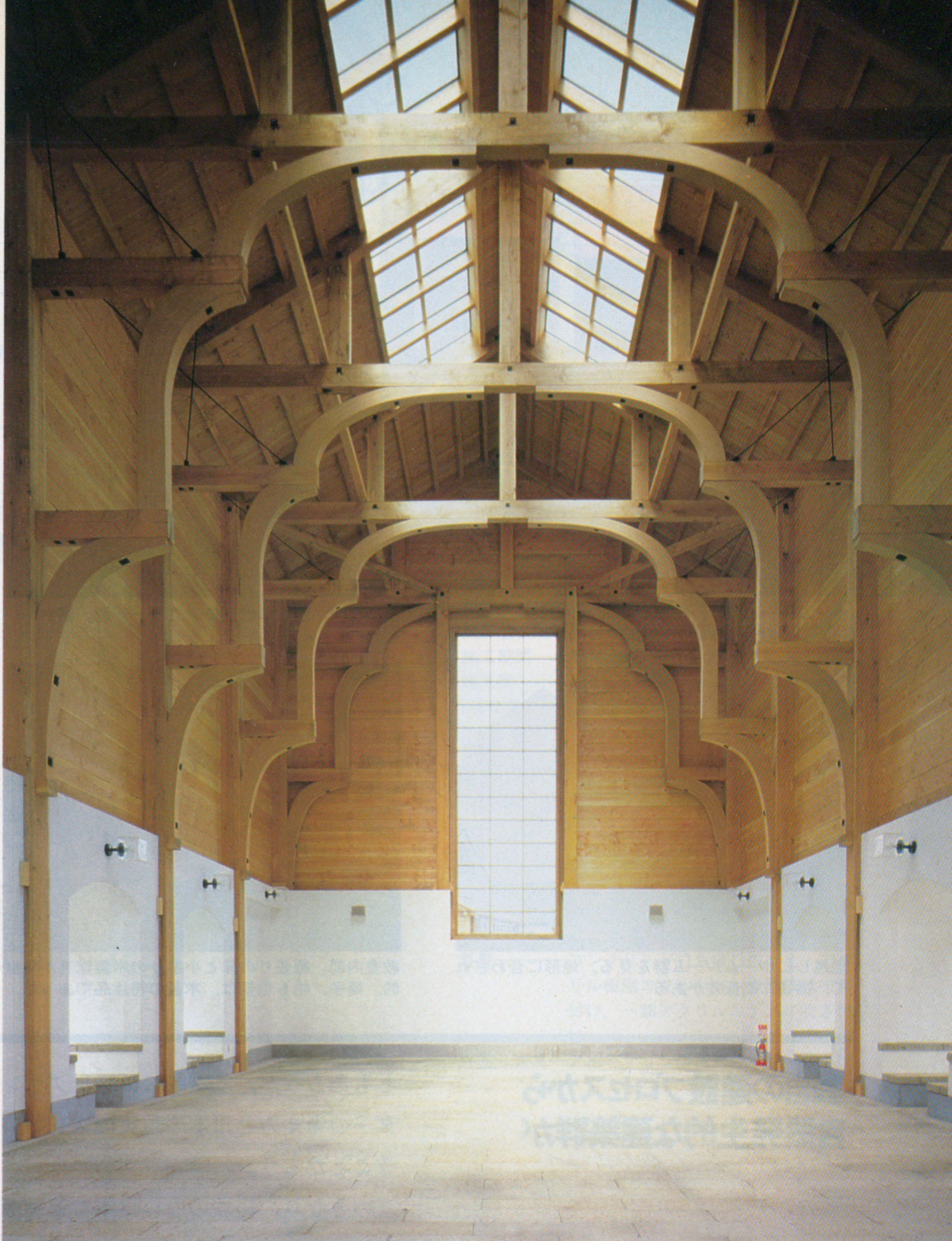
多目的ホールの内観。曲がり材を用いた木造小屋組み、白い塗り壁、大谷石の床仕上げなど、清楚な感じは教会を思わせる
