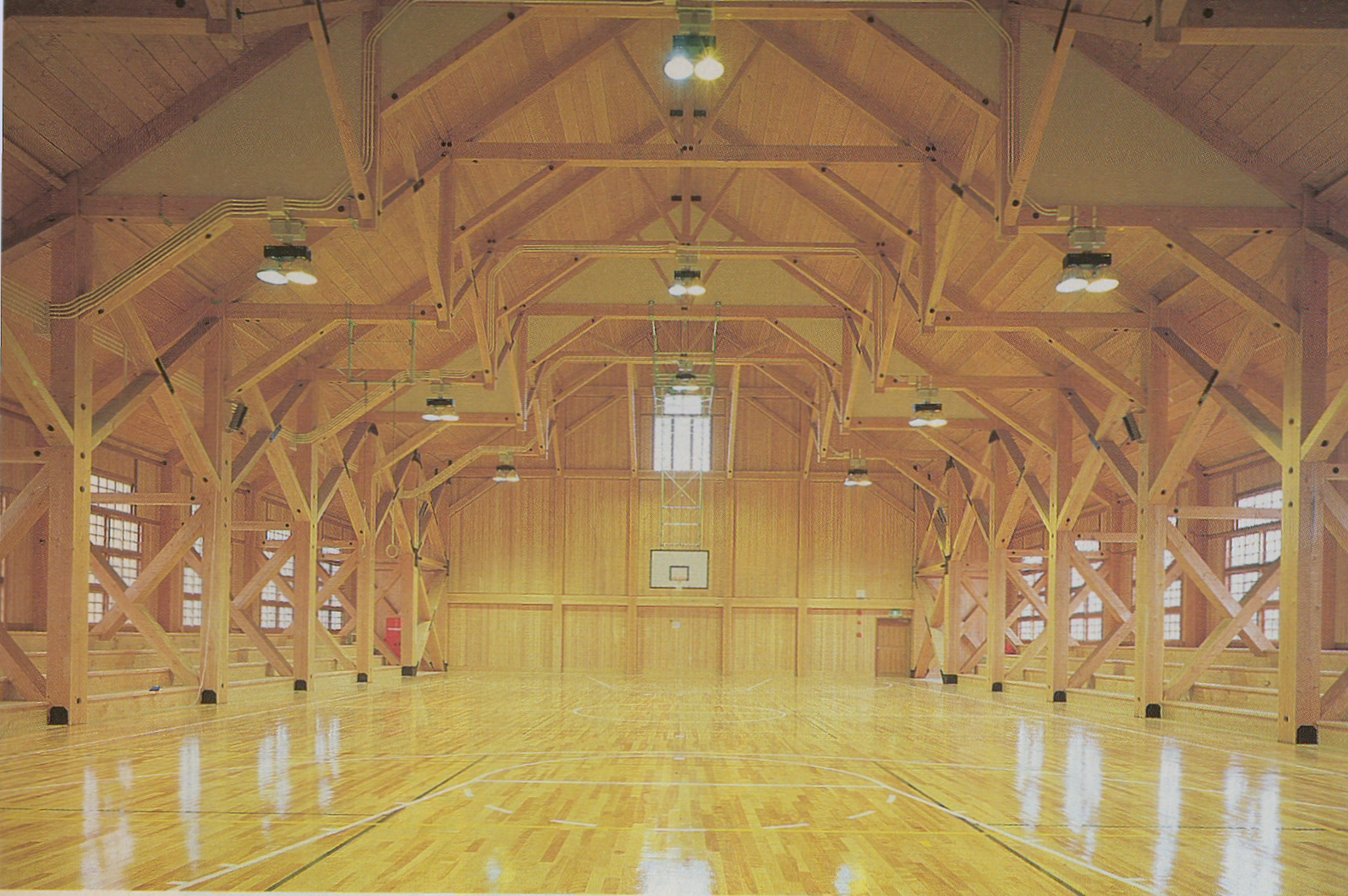
体育館の内観。レッドウッドによる木造建物。太い部材とユニークな架構には迫力がある
