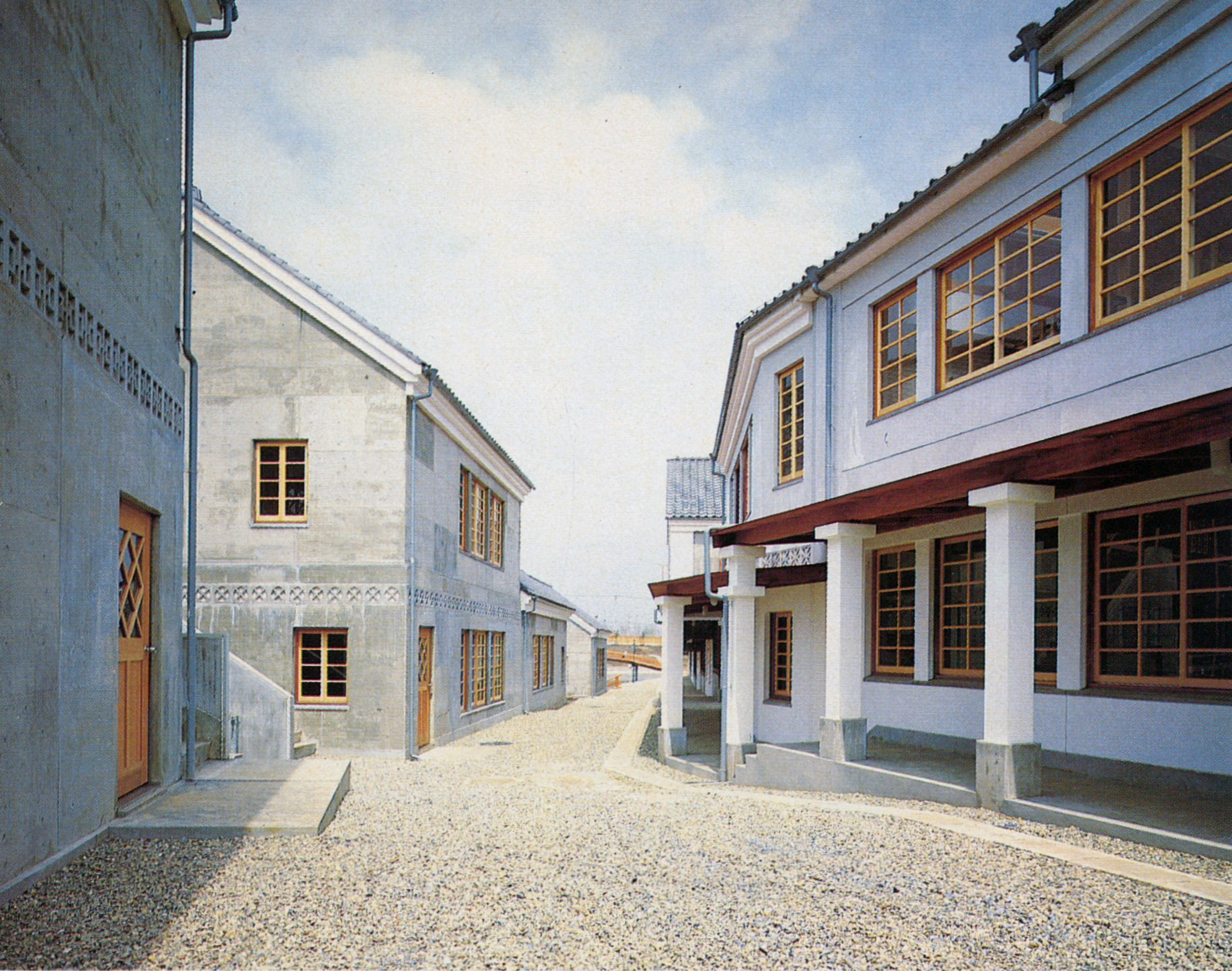
特別教室と教室棟に挟まれた路地的な空間。右側のアーケードは奥に行くと、地形に従い下がっていく
