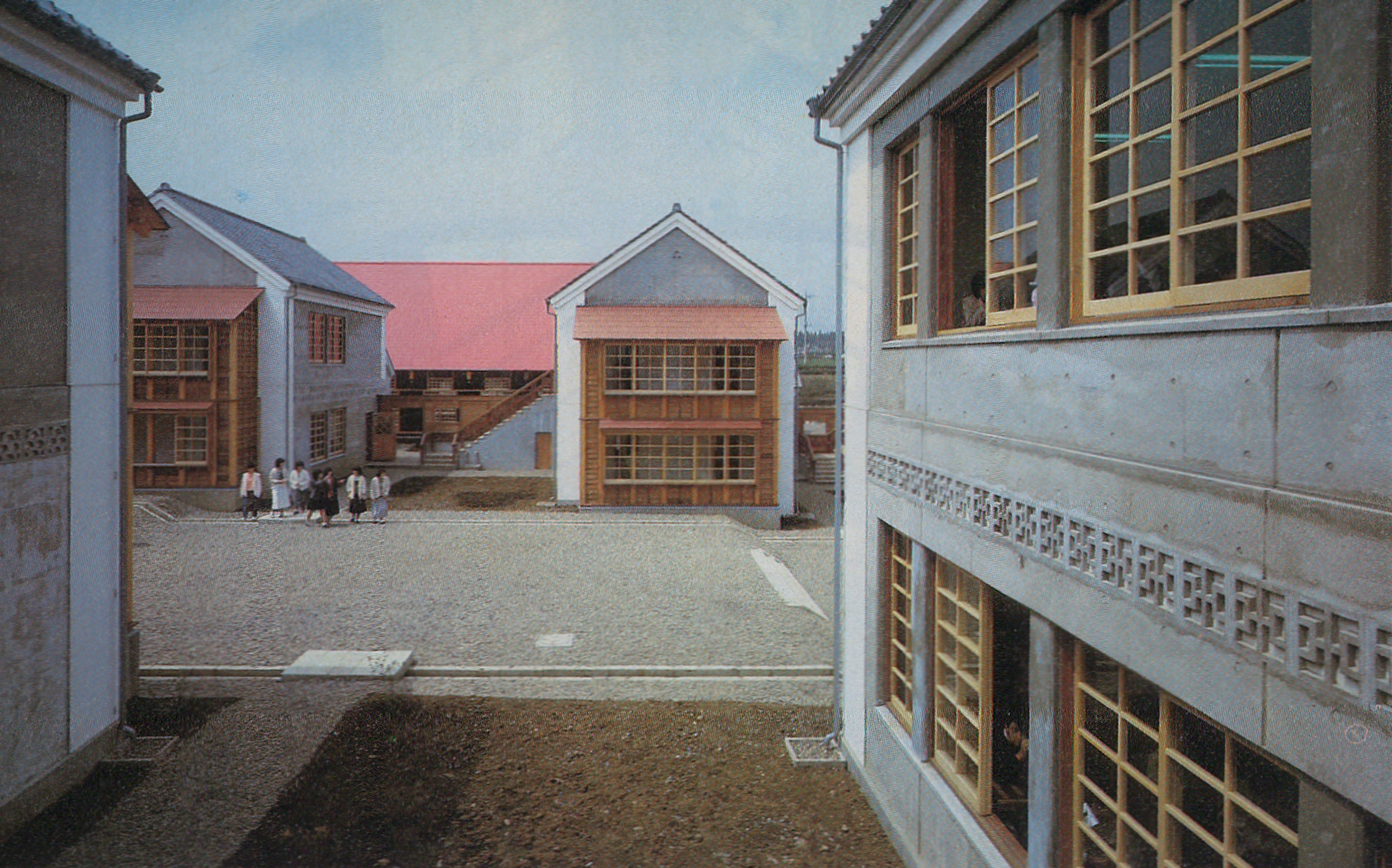
ホームルーム回り。当初案はコンクリートブロック造であったが、現在は鉄筋コンクリート造。塀やベンチなどのしつらいが未完成という
