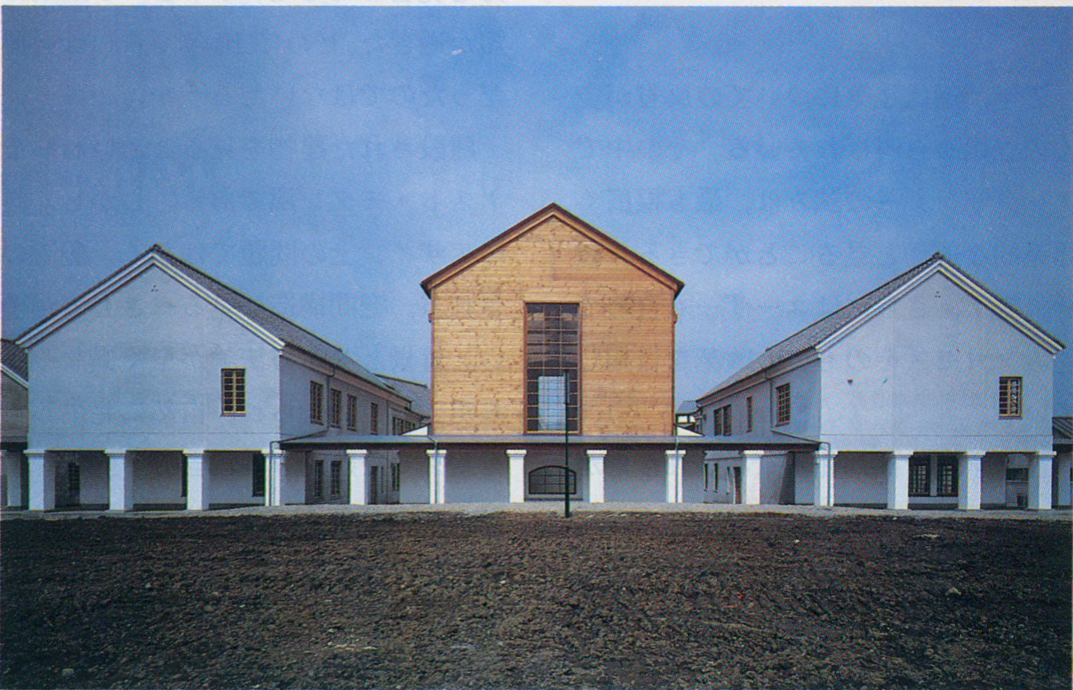
多目的ホールを挟んで特別教室棟がある。それらは、列柱に支えられたアーケードにより結ばれる
